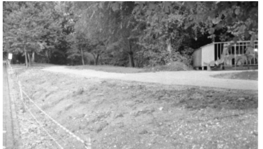
Im Vordergrund die neu angesäte Böschung der Anlage «In der Au», die vom Aubach überspült wurde, rechts oben ist das Gelände zu sehen, unterhalb dessen der Aubach in den unterirdischen Kanal fliesst.
