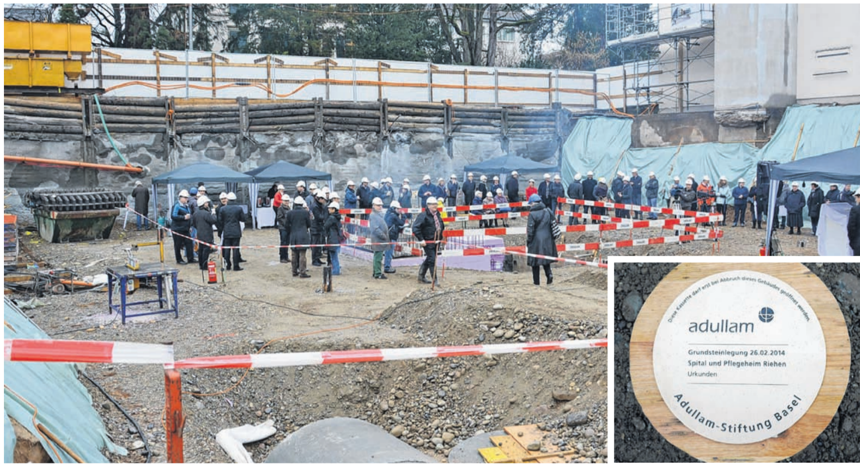
Zahlreiche Gäste aus Politik und Verwaltung fanden sich auf der Baustelle ein, um den Grundstein zu sehen.
