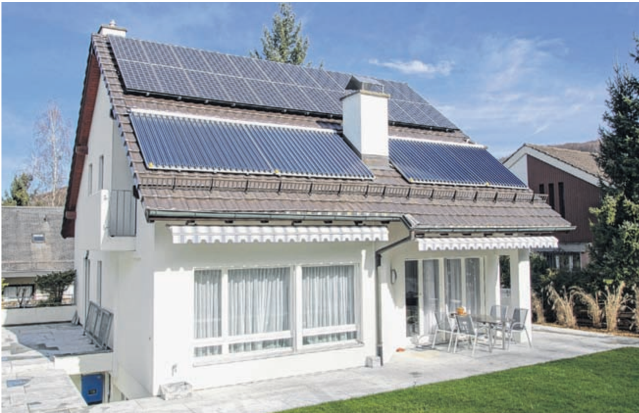
Das Haus von Beat Fehr in Bettingen ist mit einer Solaranlage ausgerüstet – und im Zusammenhang mit dem Solarenergie-Abend Bettingen vom 4. Juni zu besichtigen.
