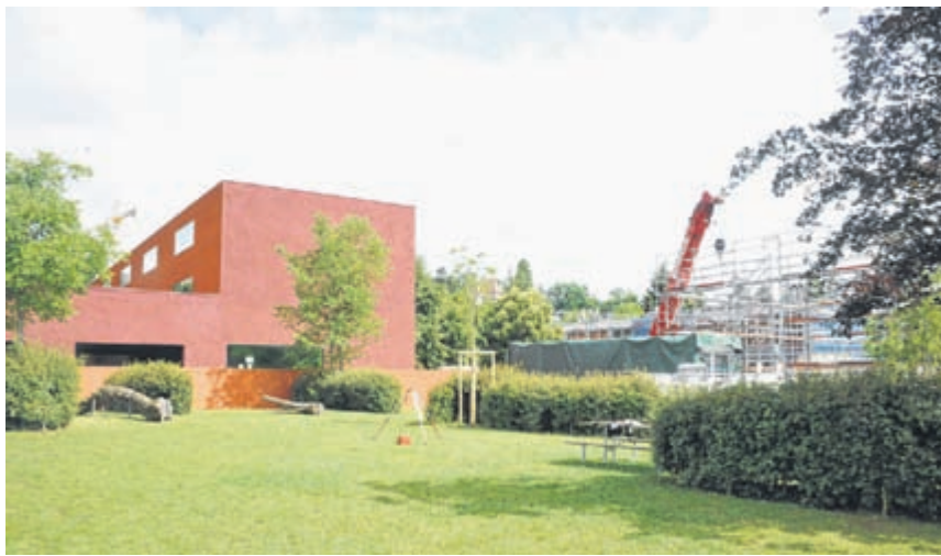
Baustelle Schule: Im Moment werden beim Schulhaus Hinter Gärten die provisorischen Ergänzungsbauten aufgestellt – bald soll im Schulbereich aber mehr Ruhe einkehren.
