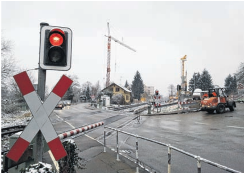
Soll Ende April der Vergangenheit angehören: Das Warten hinter den Bahnschranken am Bahnübergang «Hörnle».
