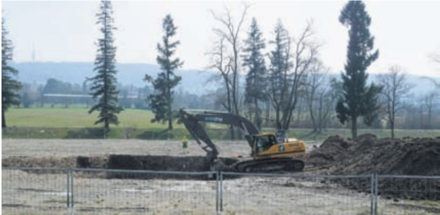
Erste Aushubarbeiten für das Naturbad haben begonnen.
