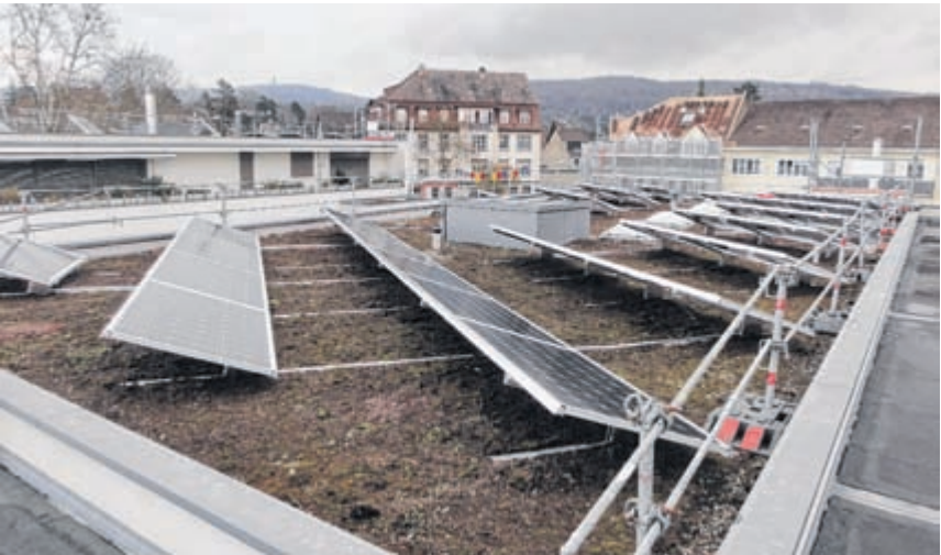
Blick auf das Dach des Hauses Nummer 262 mit lauter Fotovoltaikpanelen, im Hintergrund sieht man das Dach des Hauses 260, links die steiler gestellten thermischen Solarzellen.
