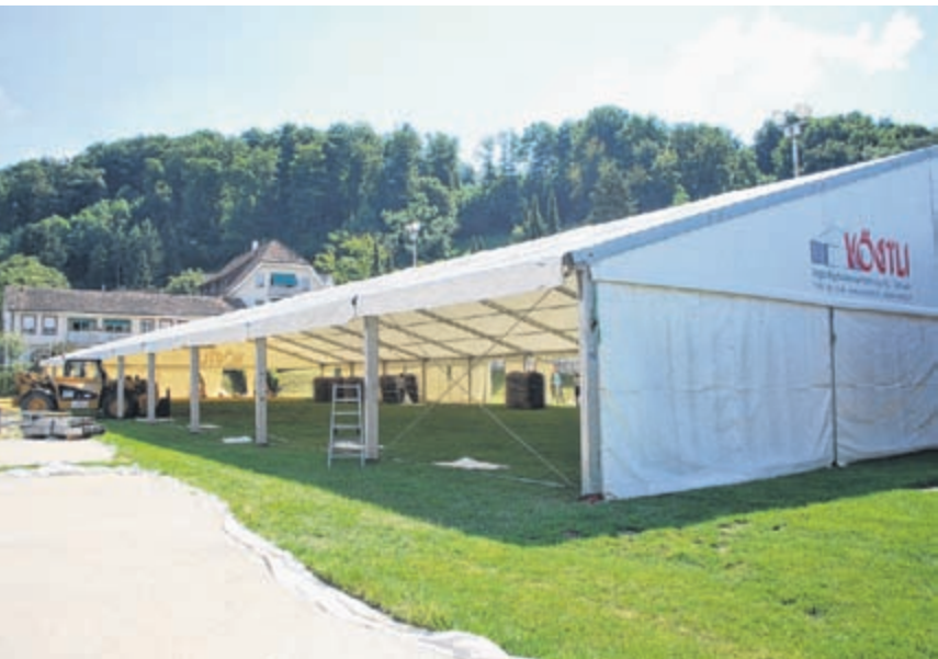
Auf dem Turnplatz unterhalb des Gemeindehauses wird ein grosses Festzelt für rund 1100 Gäste errichtet.
