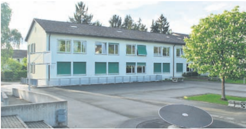
Das Gebäude der Sprachheilschule Riehen vom Schulhof her gesehen.
