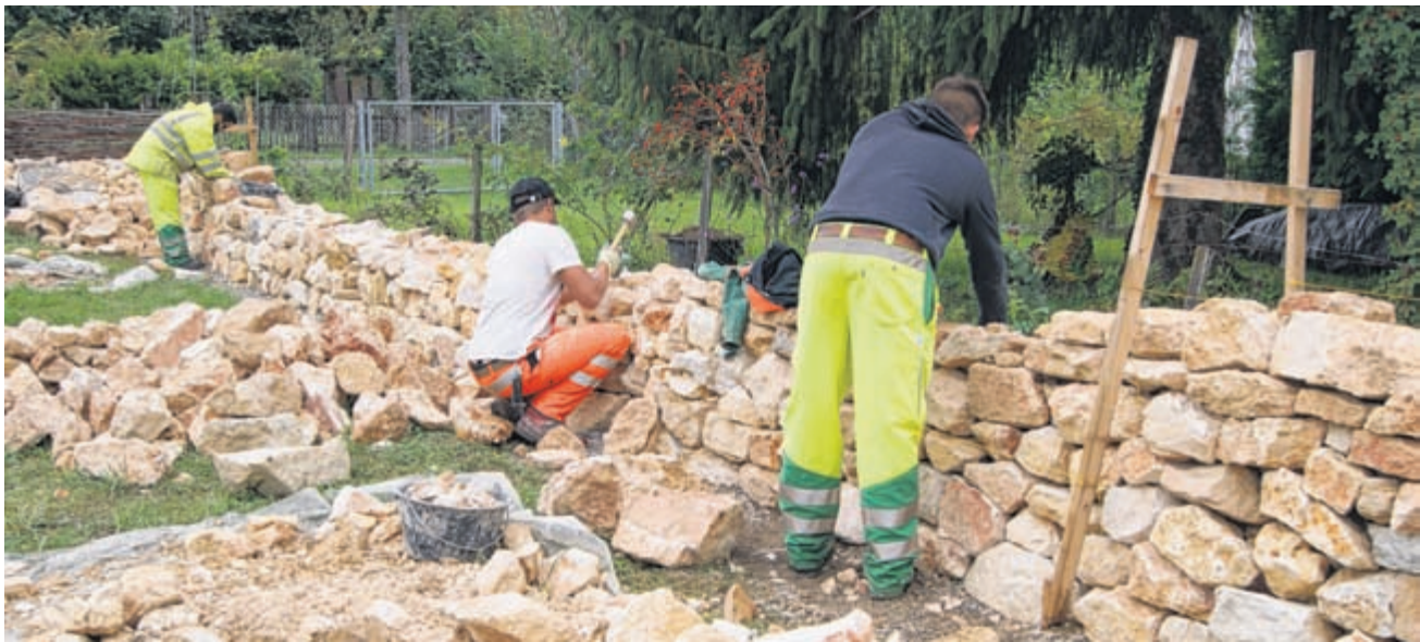
Das Errichten einer frei stehenden Trockenmauer ist anspruchsvoll. Lehrlinge der Gemeinde Riehen und der Basler Stadtgärtnerei bei der Arbeit.
