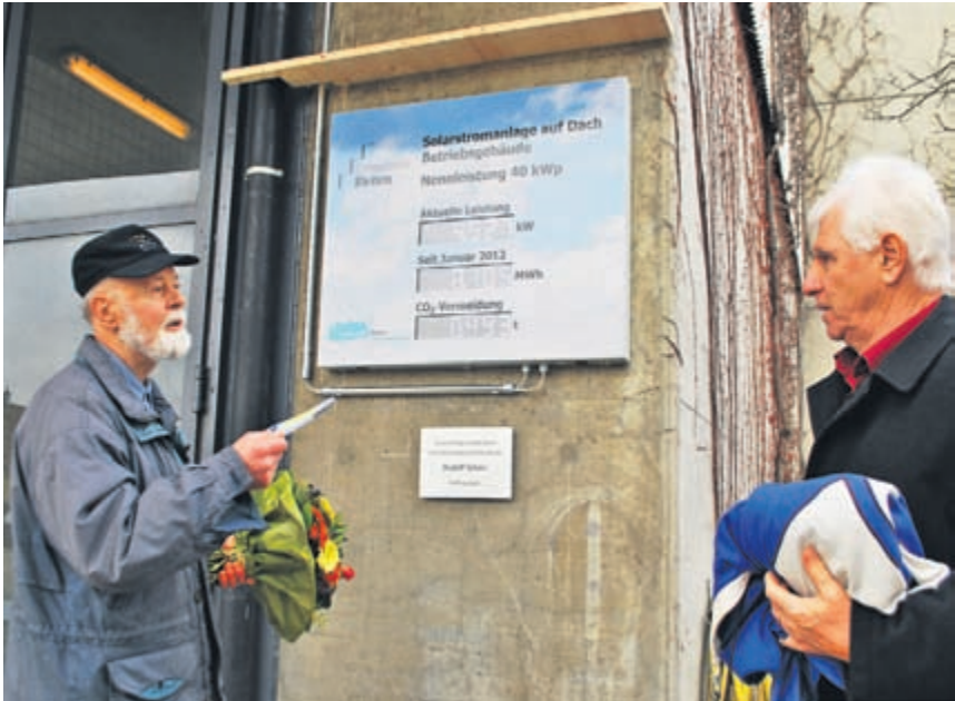
Rudolf Schori und Gemeindepräsident Willi Fischer vor der Anzeigetafel der neuen Solaranlage im angeregten Gespräch.
