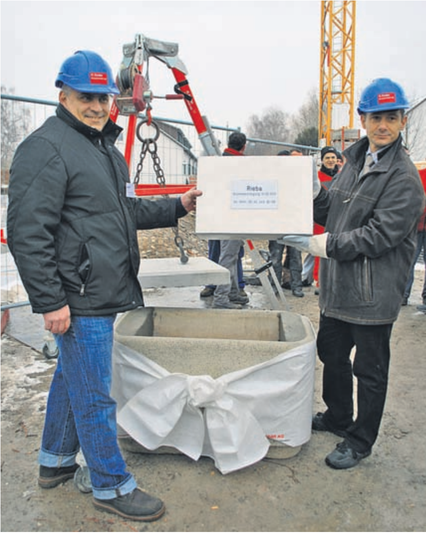
Ein Metallbehälter mit Zeitungen, Plänen und allen Adressen der Verantwortlichen wurde durch Genossenschaftspräsident Roland Tschopp (rechts) und Baukommissionsmitglied Beat Tschabold in den Grundstein eingeschlossen.
