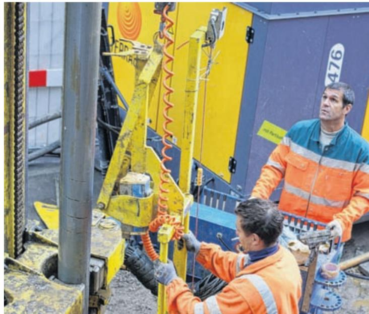
Nachdem die Erdsonde im Untergrund platziert wurde, werden die Rohre wieder aus dem Bohrloch herausgezogen.
