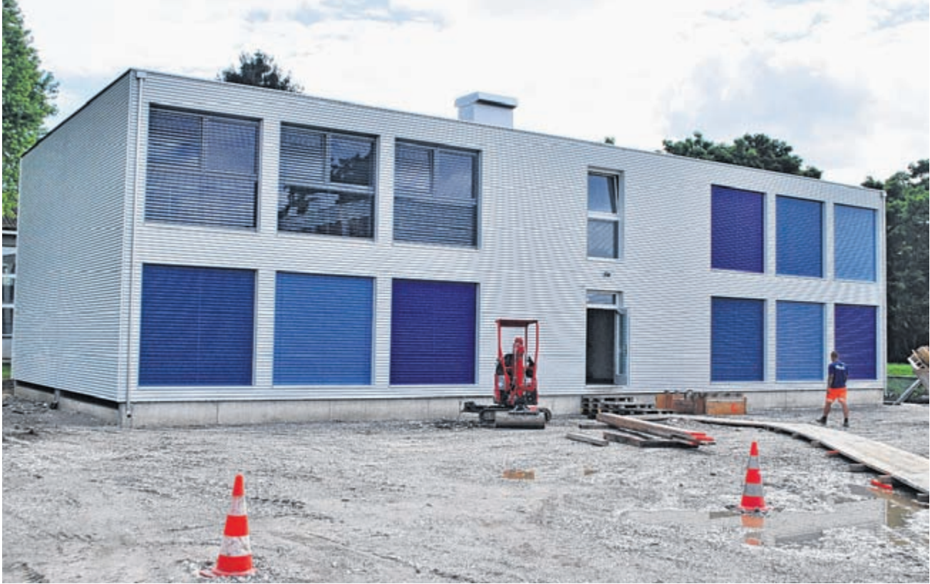
So sieht ein fertiges Gebäude aus: Schulraumprovisorium beim Basler Hirzbrunnenschulhaus mit Klassenzimmern, Zusatzräumen und sanitären Anlagen.
