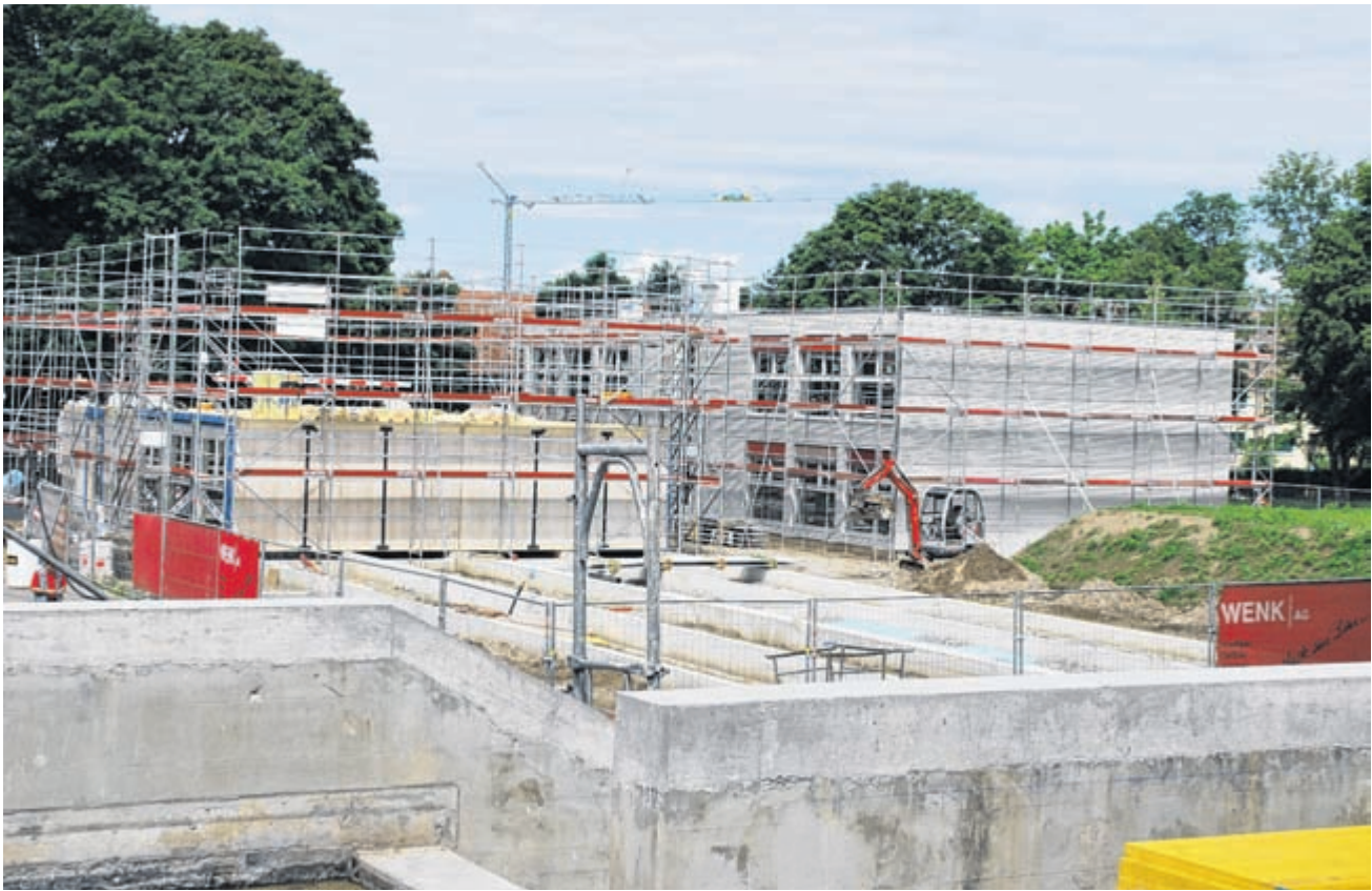
Baustelle an der Niederholzstrasse: Auf der Spielwiese werden Schulraumprovisorien für das Hebelschulhaus aufgestellt.
