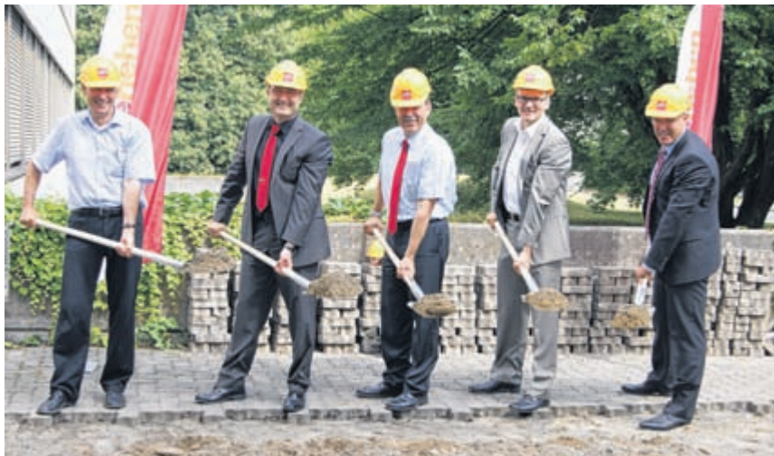
Gemeindepräsident Willi Fischer, Jürg Kunz und Marcel Schweizer vom Wärmeverbund Riehen, Marius Keller von Immobilien Basel-Stadt und Edwin van Velzen von der IWB beim ersten Spatenstich.
