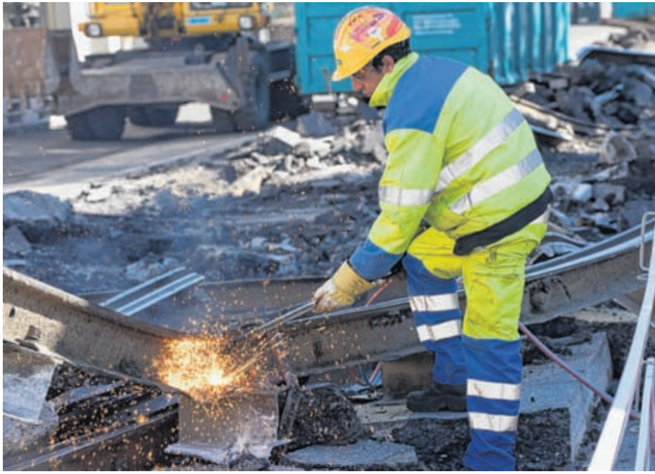
So sah es zu Beginn aus: Die alten Gleise wurden bereits am ersten Tag aus der Baselstrasse gerissen, in Stücke geschnitten und zum Altmittel geworfen.
