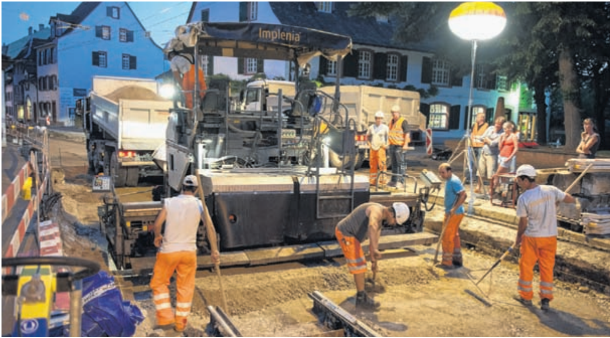
So sah es zu Beginn aus: Die alten Gleise wurden bereits am ersten Tag aus der Baselstrasse gerissen, in Stücke geschnitten und zum Altmittel geworfen.
