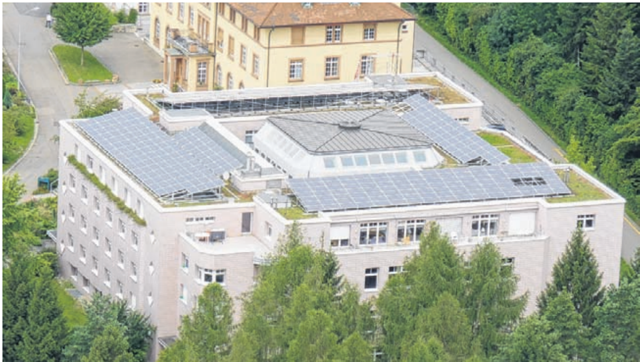
Sie steht bereits: Die Photovoltaik-Anlage auf dem Dach des Konferenzentrums St. Chrischona.
