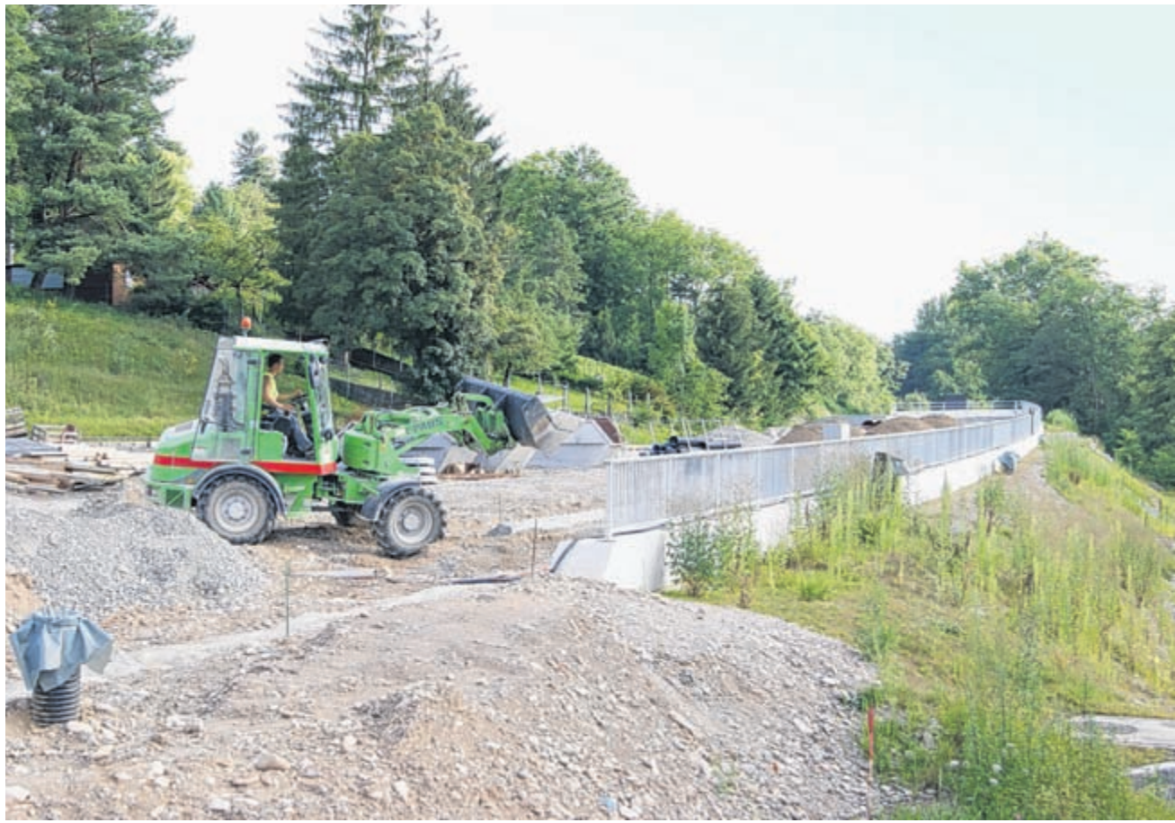
Der Bau der Zollfreistrasse schreitet voran. Das Teilstück auf dem Areal des zukünftigen Naturbads kann jedoch erst Ende Oktober abgenommen werden. Das Freibad kann deswegen erst später gebaut werden. Foto: Michèle Faller
