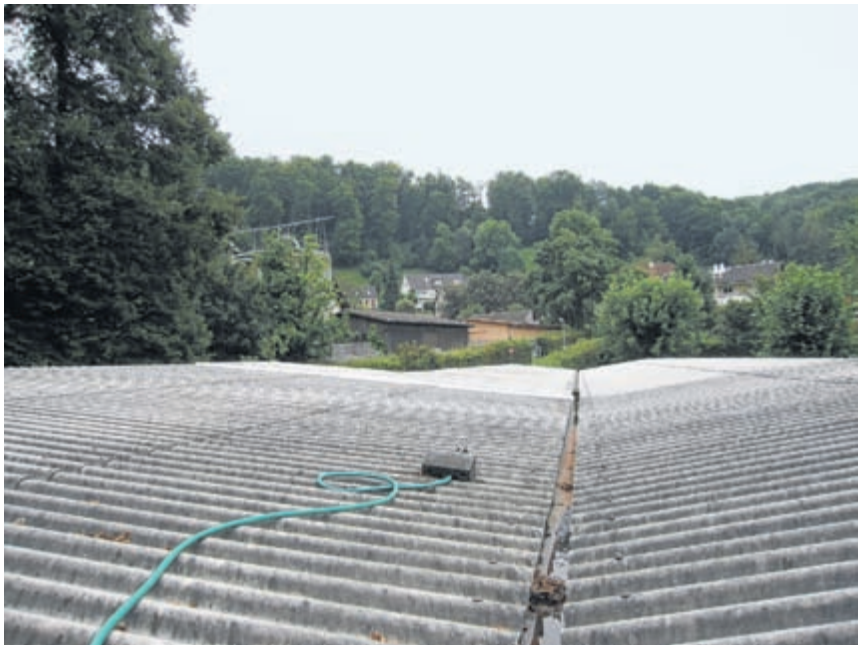
Unauffällig auf das Dach gelegt: die Sonnenkollektoren des Bettinger Gartenbads, die das Duschwasser wärmen und das Wasser im Pool aufwärmen helfen.
