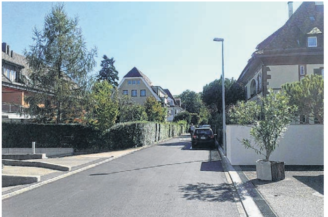
Neu installierte Natriumdampfampe an der Paradiesstrasse.
