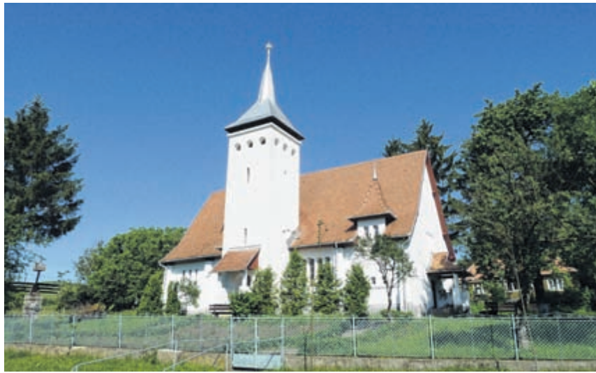
Die reformierte Kirche in Póka: Mit Hilfe der Kirchgemeinde Riehen-Bettingen erstrahlt sie wieder in neuem Glanz.
