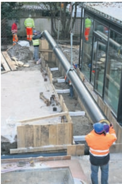
Hier werden richtig Rohre verlegt – am Samstag wird es spielerisch und es gibt einen Preis.
