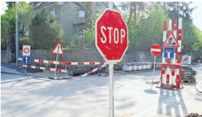
In der Nähe der Baustellen sollten Passanten besonders aufmerksam sein. Auch wenn es bisweilen schwierig ist.
