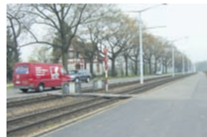
Dieser Übergang wird aus Sicherheitsgründen aufgehoben. Foto: BVB
