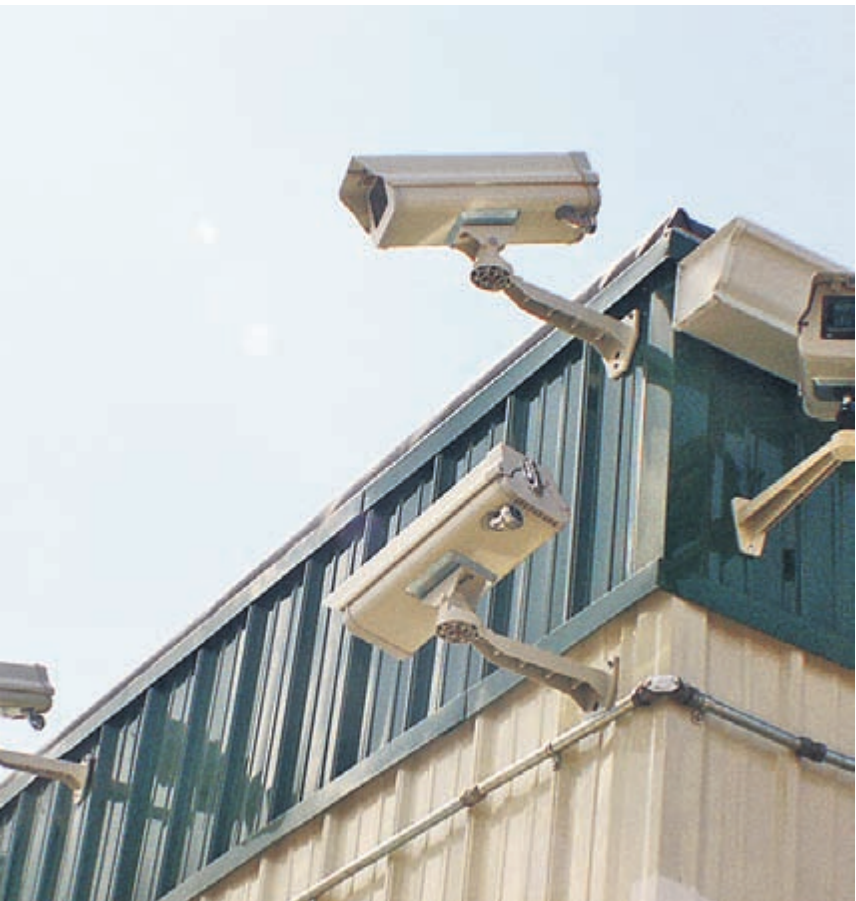
Bei der Montage von Aussenkameras zur Gebäude- und Geländeüberwachung ist Knowhow gefragt, damit verwertbare Aufnahmen entstehen. Foto: zvg
