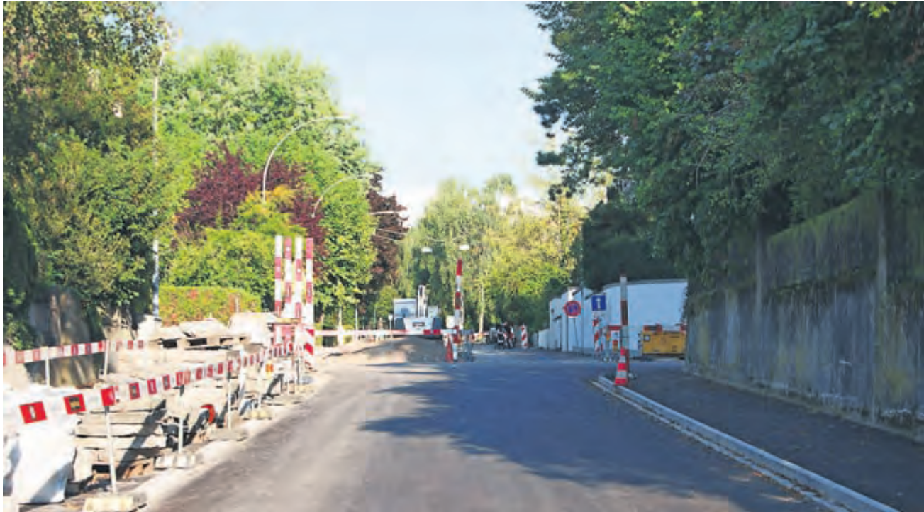
Auf dem vordersten Teil der Kilchgrundstrasse (Anschluss Aeussere Baselstrasse) sind die Arbeiten bereits beendet, die Tragschicht ist für den Verkehr geöffnet.
