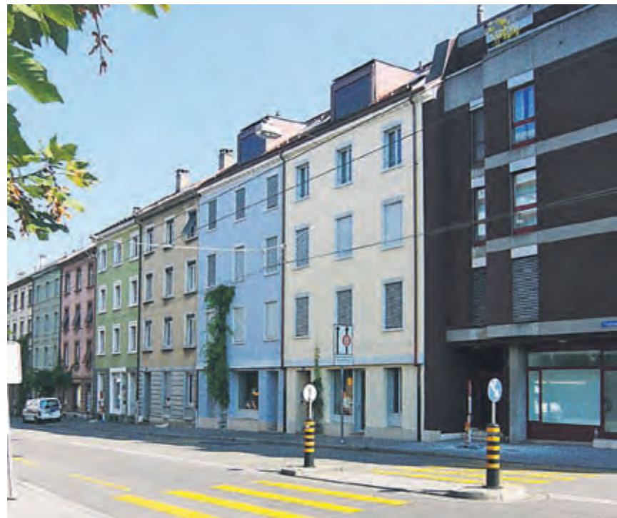
Selbstversorger: Das Mehrfamilienhaus an der Feldbergstrasse 4 und 6.
