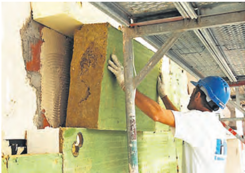
Isolieren hilft – bis zu 80 Prozent der Heizkosten können eingespart werden. Ein gelungenes Beispiel an der Feldbergstrasse 4 und 6.
