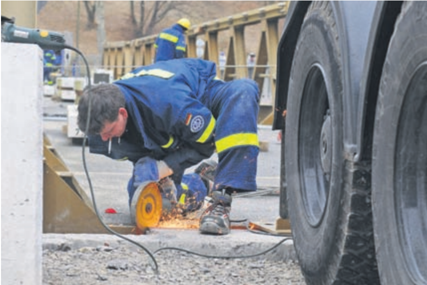
Arbeiten an der Weilstrasse-Brücke
