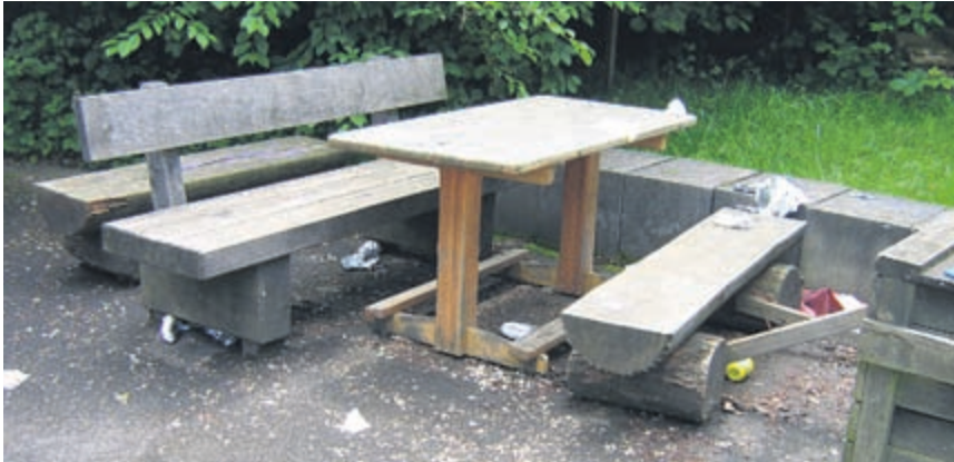
Zerstörte Sitzbank auf dem Sitzplatz beim «Spatzenäschтли».
