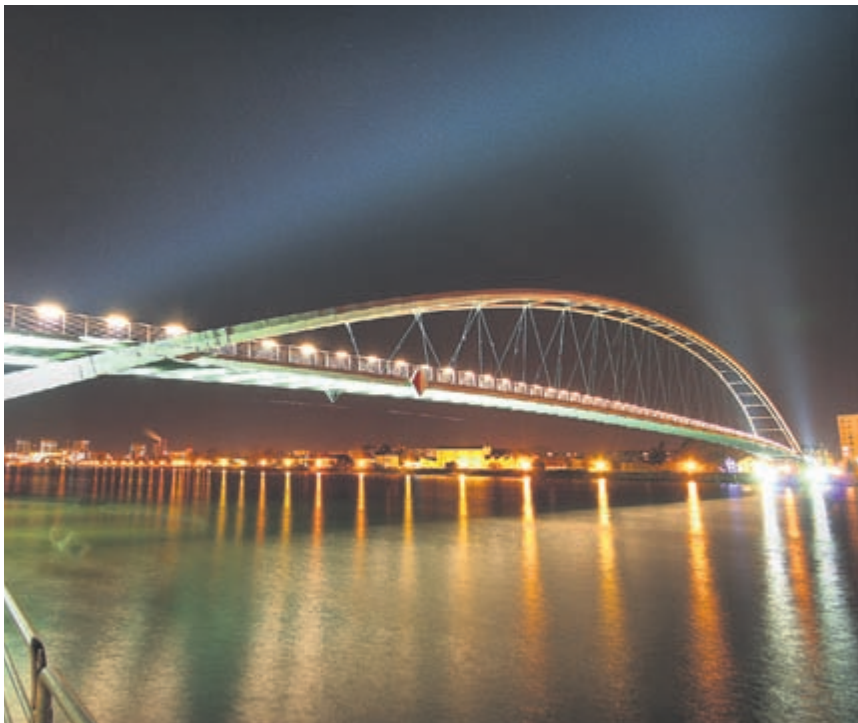
Die Dreiländerbrücke heimst Preise en masse ein.
