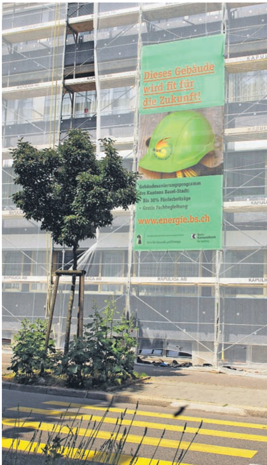
Gebäude aus dem Gesamtsanierungsprogramm.
