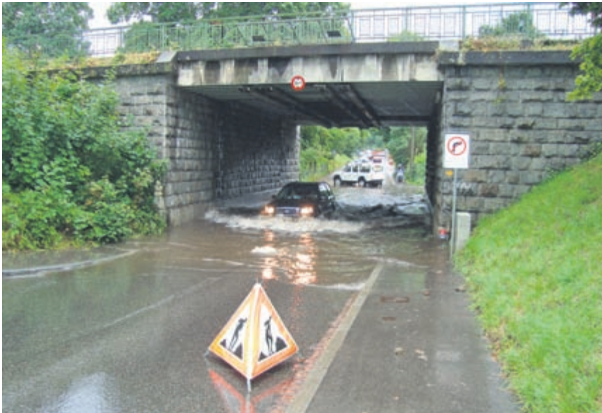
Es regnet heftig am 10. August, bis zu 29 Liter fallen zwischen 14.30 und 15 Uhr pro Quadratmeter. Die Unterführung an der Hörnliallee (und nicht nur sie) steht unter Wasser.
