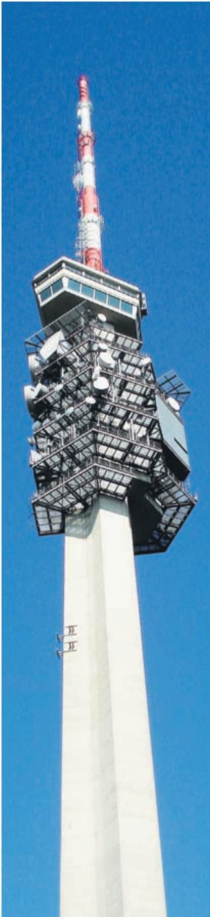
Der Sendeturm St. Chrischona ist 25 Jahre alt. 800 Personen konnten auf den Turm steigen. Die Tickets für den Besuch des Turms waren im Nu weg und die Glücklichen begeistert von der Aussicht.
