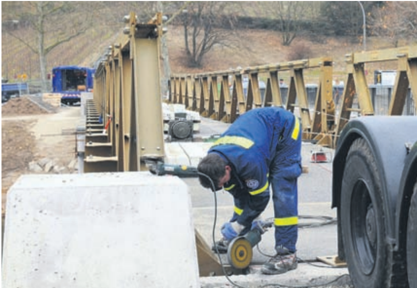
Wegen des Baus der Zollfreistrasse wird eine Behelfsbrücke über die Wiese montiert.
