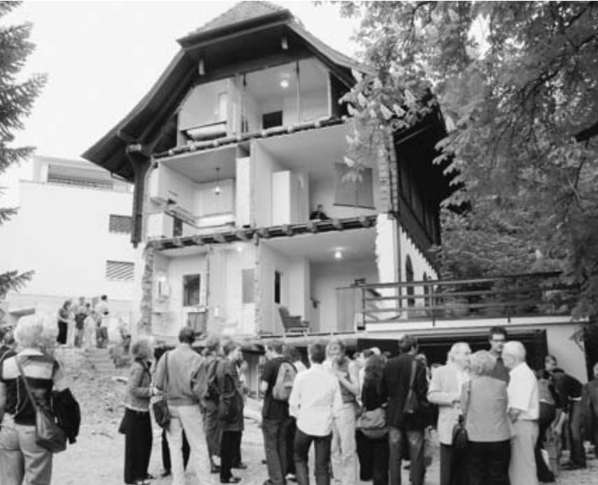
Spannende Einblicke in das Innenleben eines Hauses bot Ende April die Intervention der Künstlerin Ruth Widmer in einer Abbruchliegenschaft am Hohlweg, wozu eigens die Gebäudefassade entfernt wurde.
