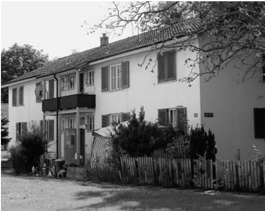
Für die wegfallenden Notwohnungen am Rüchligweg soll die Gemeinde in angemessenem Umfang Ersatzstandorte vorschlagen.
