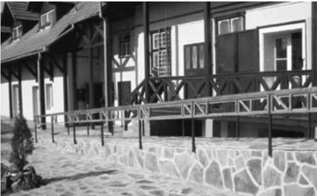
Das Haus der «Asociatia Riehen» in Miercurea-Ciuc/Csikszereda, wo das Senioren-tagesheim und die Spitz untergebracht sind.
