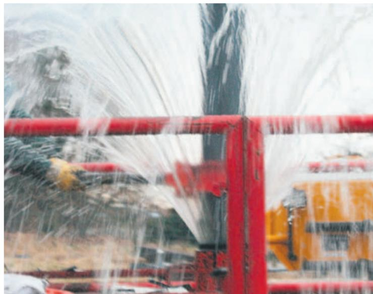
Beim Wechsel einer Pumpe beim Bohrloch am Bachtelenweg sprudelt warmes Wasser aus dem Riehener Untergrund. Foto: zVg
