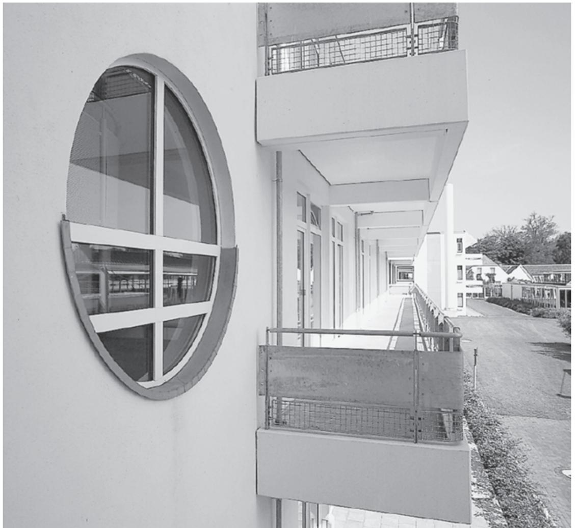
Minergie-Fenster von Aerni wie etwa dieses «Bullauge» sind aus hochwertigem Kunststoff gefertigt.
