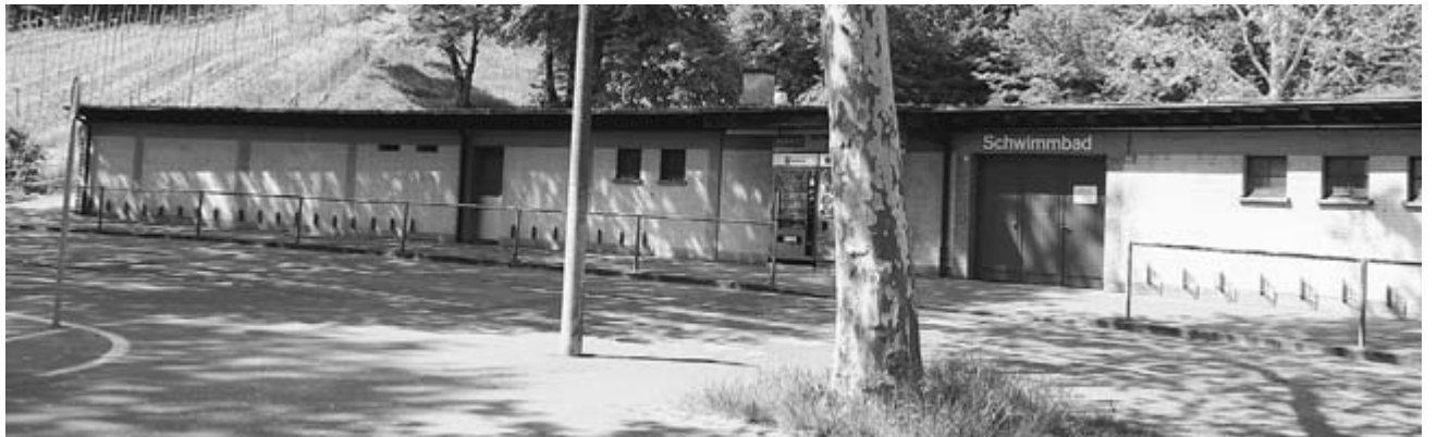
Bald ausgedient – das Eingangsgebäude der Riehener Badi.
