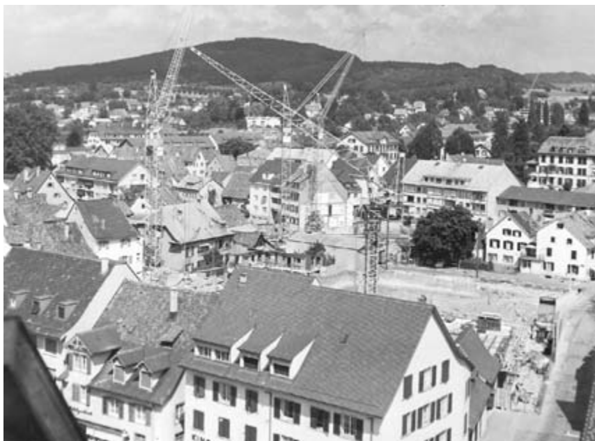
Baugrube im Dorfzentrum im Jahr 1965.
