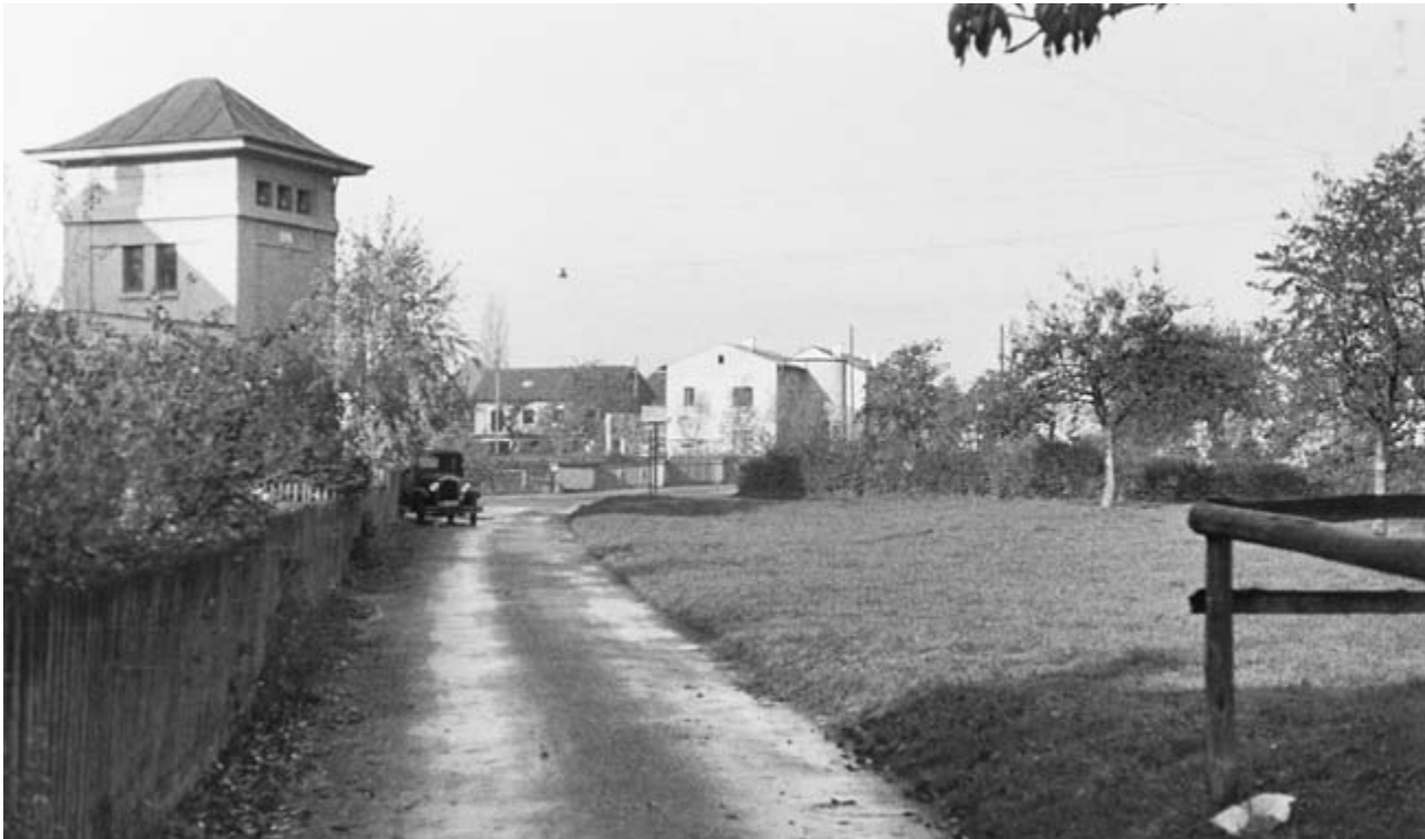
Der Grenzacherweg wurde 1932 zu einer von Bäumen gesäumten Strasse ausgebaut (Bild oben, 1934). Die in den 70er-Jahren noch unverbaute Böschung zwischen Rudolf Wackernagel-Strasse und Unterm Schellenberg war einst ein beliebter Schlittelhang (Bild Mitte, 1974). An der Ecke Morystrasse/Lachenweg steht seit 1926 die Transformatorenstation des damaligen EWB, heute IWB (Bild unten, 1934).
