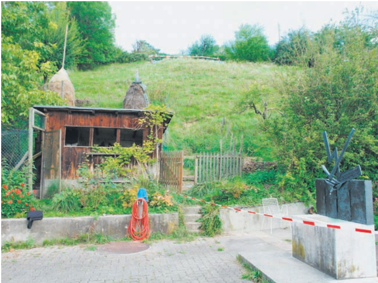
Der Rutschhang liegt gleich oberhalb des Zollfreistrasse-Brunnens von Bettina Eichin auf einem Privatgrundstück. Gut erkennbar ist am oberen Bildrand der durch Baubabschrankungen gesicherte Abrissbereich. Foto: Dieter Wüthrich
