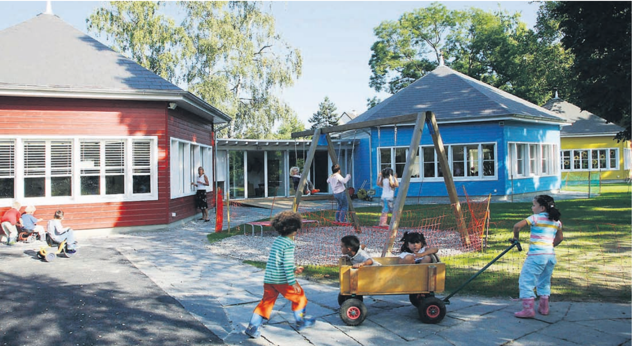
Die vorher überdachten Aussenräume zwischen den Pavillons wurden mit grosszügigen Fensterfronten geschlossen und beherbergen nun zusätzliche Gruppenräume. Fotos: Donata Ettlin
