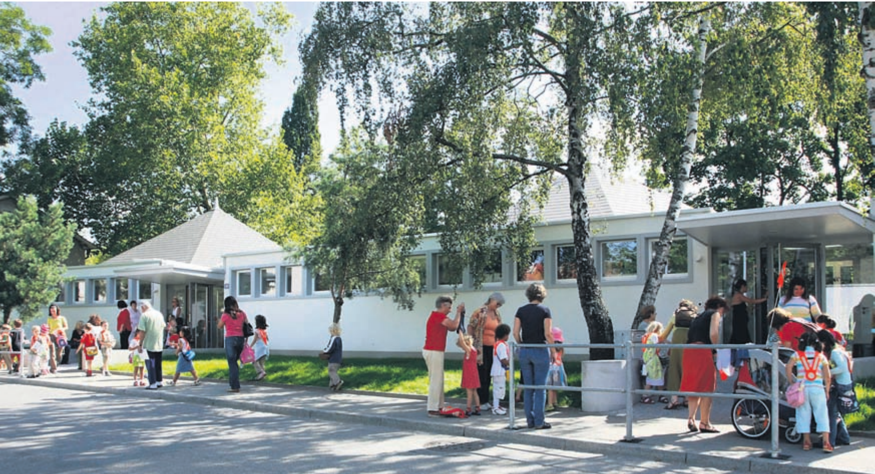
Die neu geschaffenen Eingänge fügen sich wie selbstverständlich in den Bestand ein, ohne dass sie das charakteristische Aussehen der Strassenfassade grundlegend verändern.
