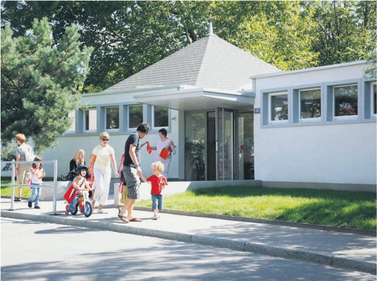
Das Erscheinungsbild mit den stilbildenden Betonrahmen der Fensteröffnungen auf der Strassenseite galt es beizubehalten.
