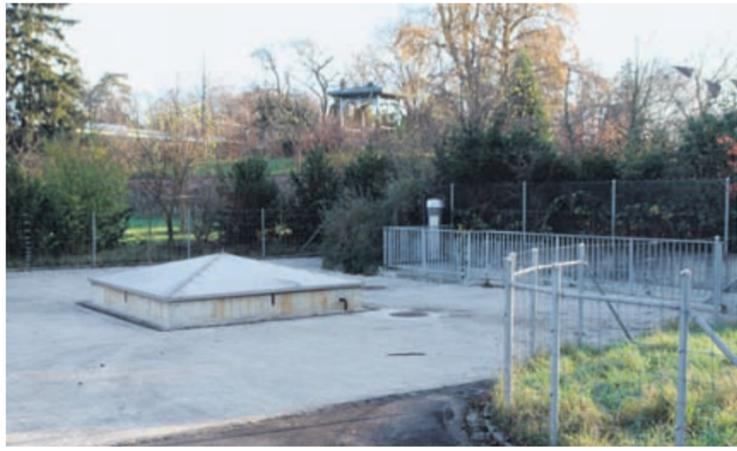
An der Entnahmestelle am Bachtelenweg wird das Wasser für den Wärmeverbund aus einer Tiefe von 1500 Metern hochgepumpt. Foto: Rolf Spriessler
