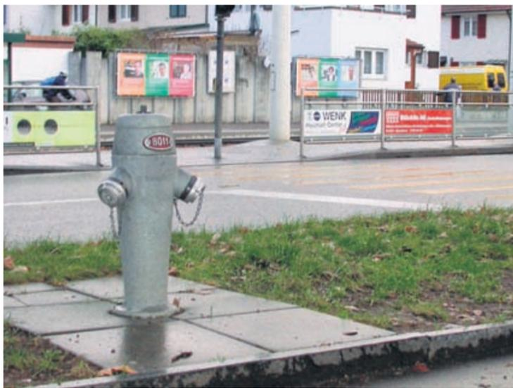
Gut sichtbar – wie hier an den Habermatten – sind die Überflurhydranten, allerdings teurer in der Montage als Unterflurhydranten. Foto: Sibylle Meyrat
