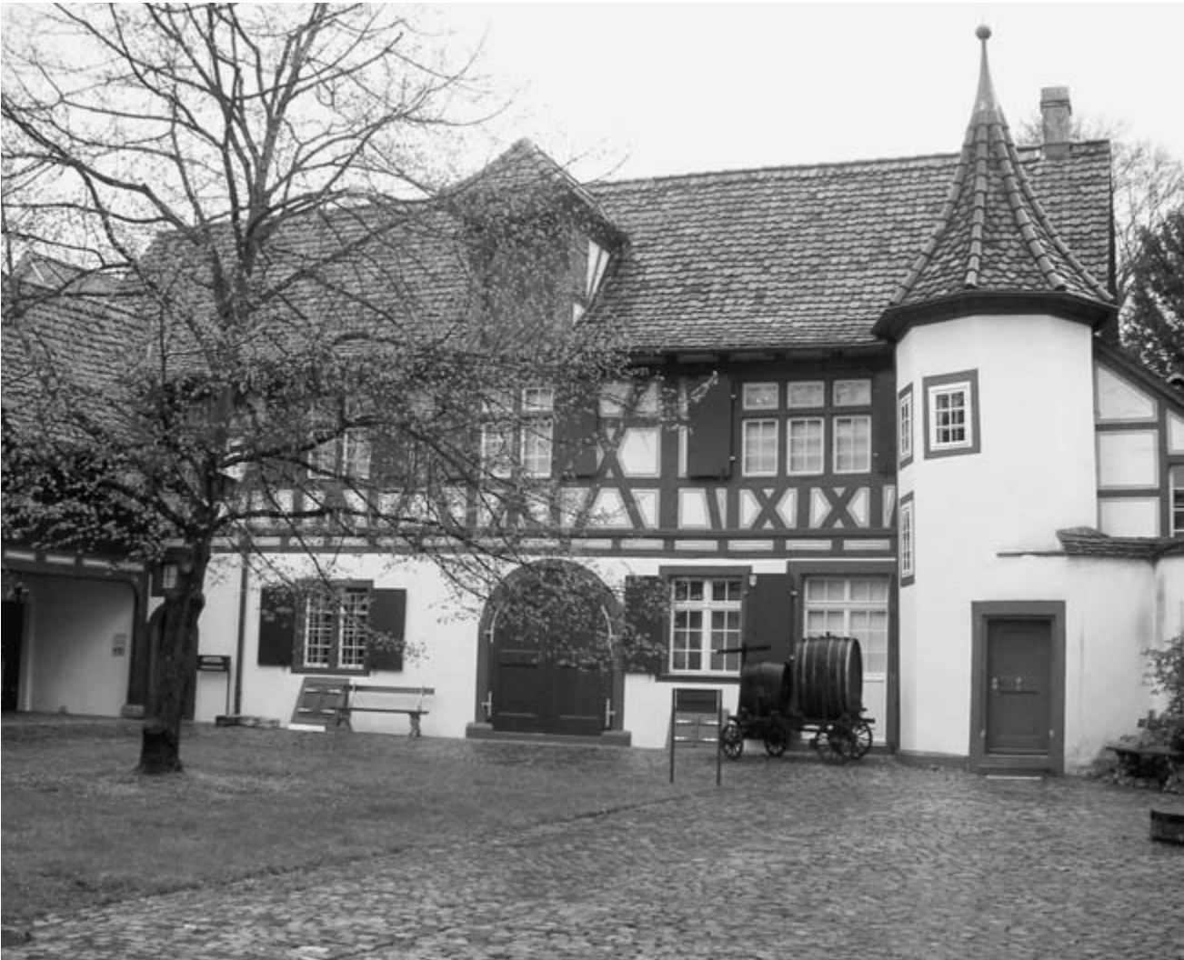
Die letzte umfassende Renovation liegt rund drei Jahrzehnte zurück. Jetzt muss das Dach des Spielzeug-, Dorf- und Rebbaumuseums saniert werden.
