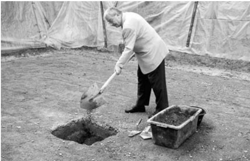
Gemeindepräsident Michael Raith legte beim Eingraben des Grundsteins selbst Hand an.
