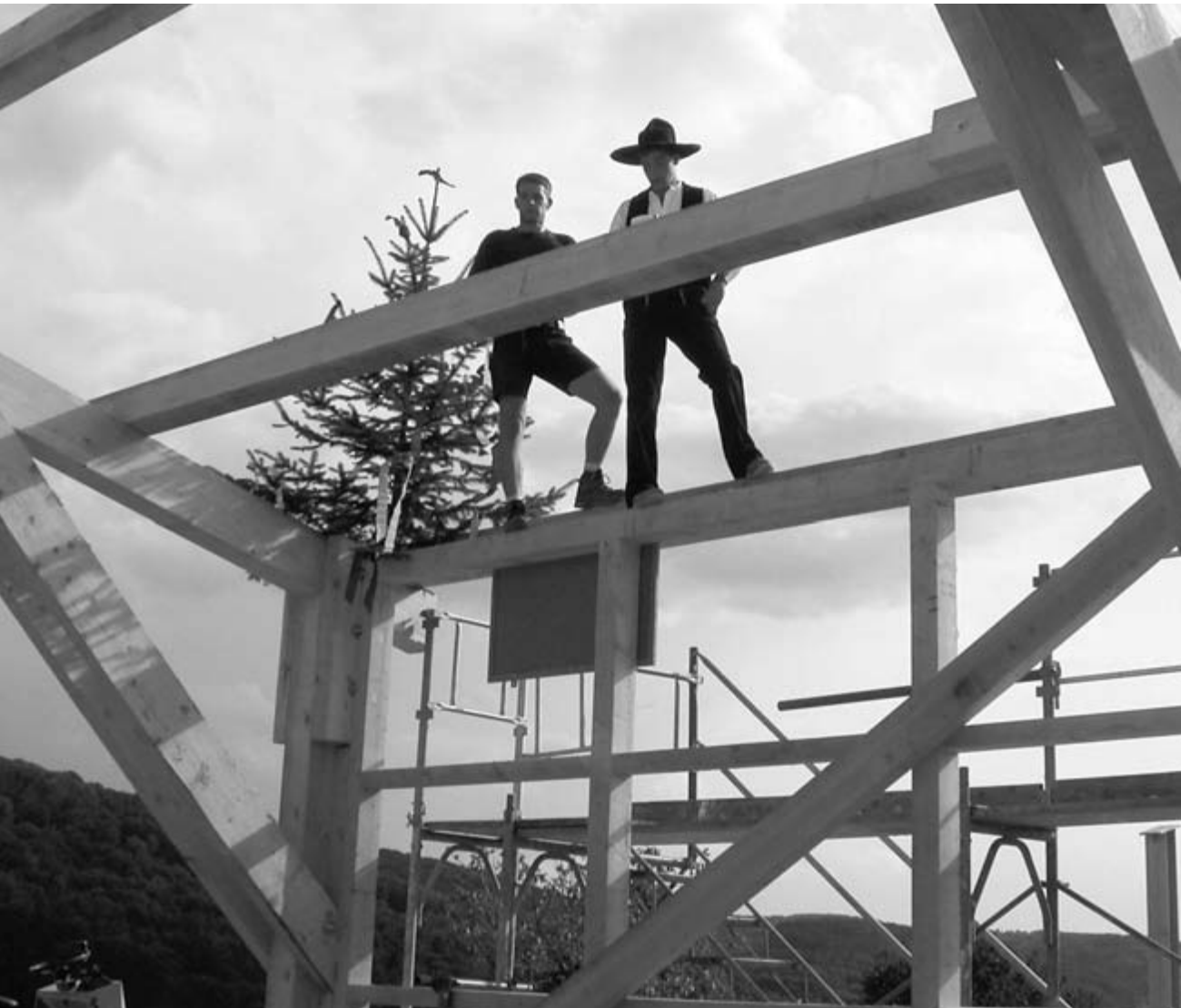
Nach alter Sitte: Der Richtspruch der Zimmermänner auf dem Stalldach des Maienbühlhofes. Foto: Franz Osswald
