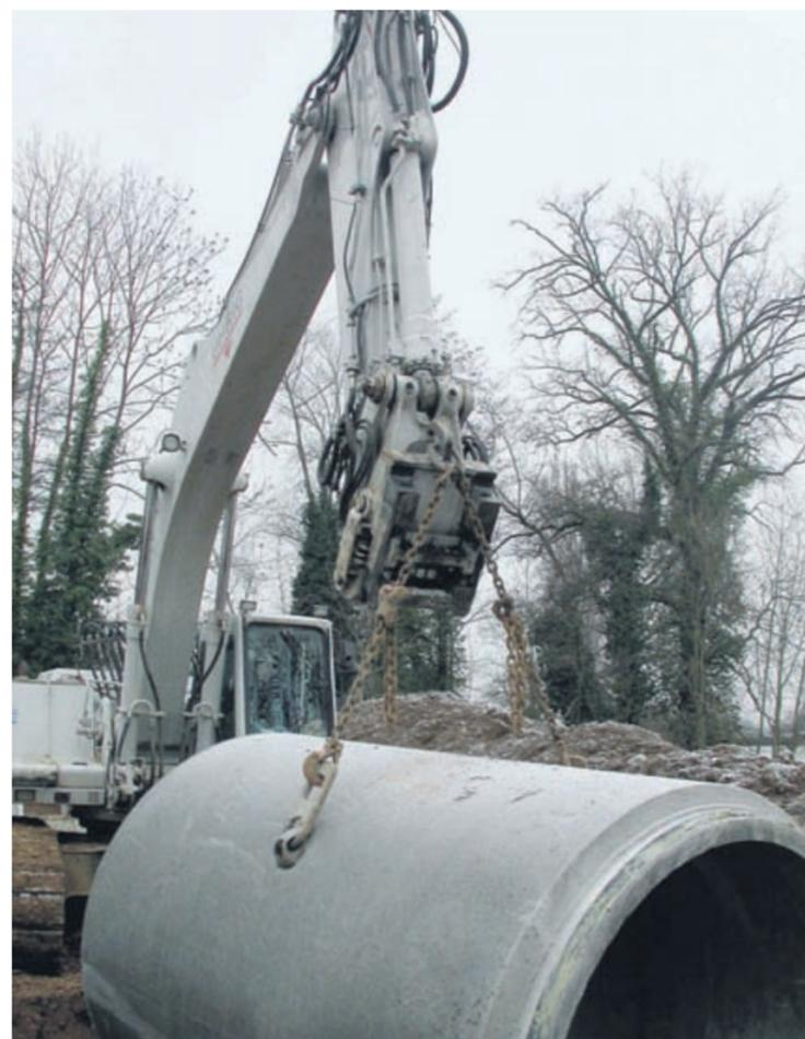
Ein elf Tonnen schweres Kanalrohrstück wird mit Hilfe eines grossen Baggers in die Erde verlegt.
