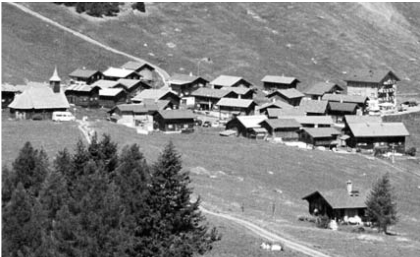
Seit dem 2. Dezember ist Mutten (Bild) zumindest provisorisch über die neue, wintersichere Erschliessungsstrasse erreichbar.
