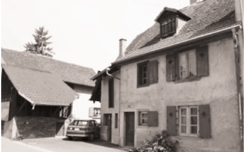
Ende Mai bewilligte der Einwohnerrat einen Kredit über zwei Millionen Franken für die Renovation der ehemaligen Tagelöhnerhäuser an der Gartengasse. Damit setzt das Gemeindeparlament ein Zeichen für die Erhaltung historisch wertvoller Bausubstanz im Dorfzentrum.
