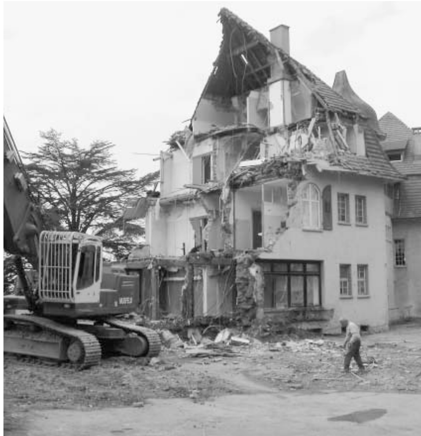
Die letzte Stunde des ehemaligen Altersheimes «La Charmille» an der Inzlingerstrasse hat endgültig geschlagen. Vor wenigen Tagen haben die Abbrucharbeiten begonnen. Auf dem Areal soll in den kommenden Monaten eine Wohnüberbauung entstehen (die RZ berichtete darüber).
