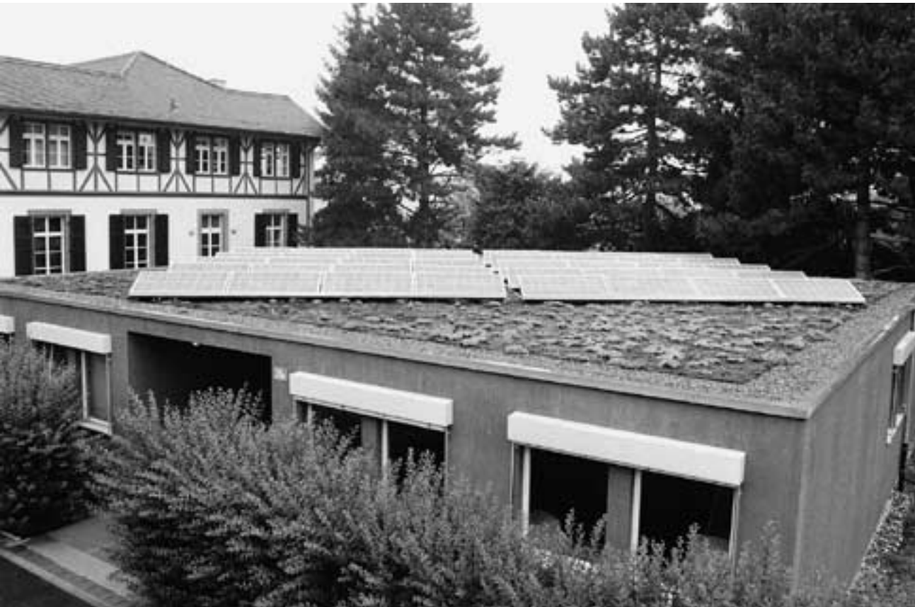
Auch die Psychiatrische Klinik «Sonnenhalde» produziert mit einer Photovoltaikanlage Solarstrom.
