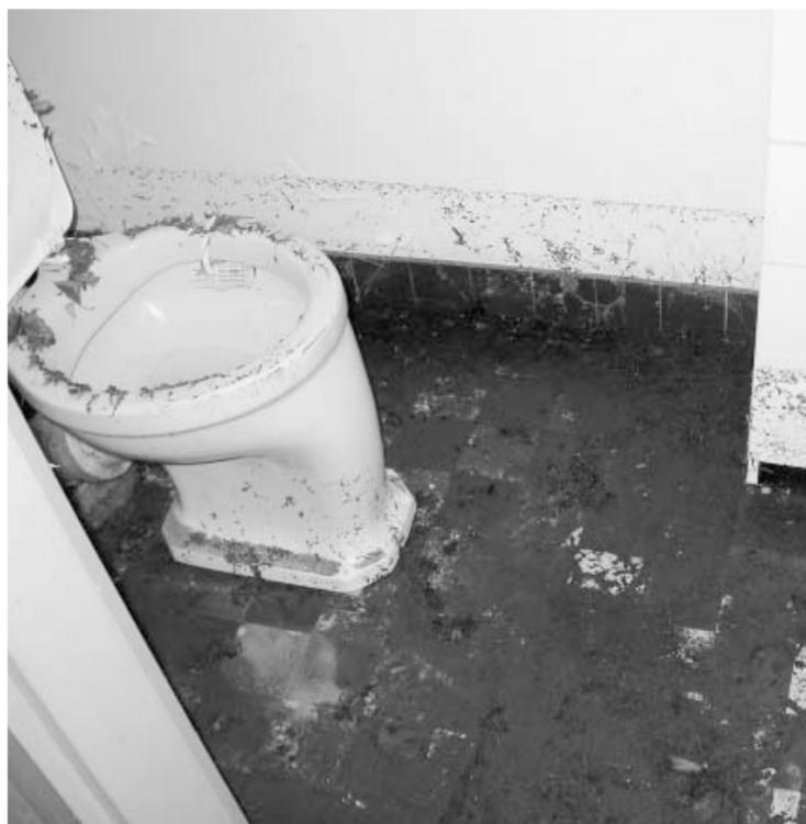
Beispiel aus einem Riehener Privathaus am Talweg: Wasser samt Schlamm drückte aus der kurzzeitig völlig überfüllten Kanalisation über eine Toilette ins Haus durch – das Wasser konnte rasch abgepumpt werden, der Schlamm blieb.
