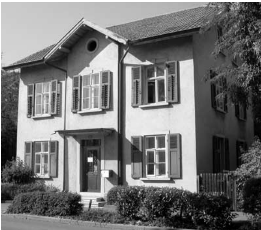
Neuer Anlauf: Die zwischenzeitlich von der Sozialhilfe Riehen genutzte Liegenschaft Bahnhofstrasse 34 soll einem Neubau weichen. Dafür sucht der Gemeinderat jetzt eine private Bauträgerschaft. Foto: Rolf Spriessler
