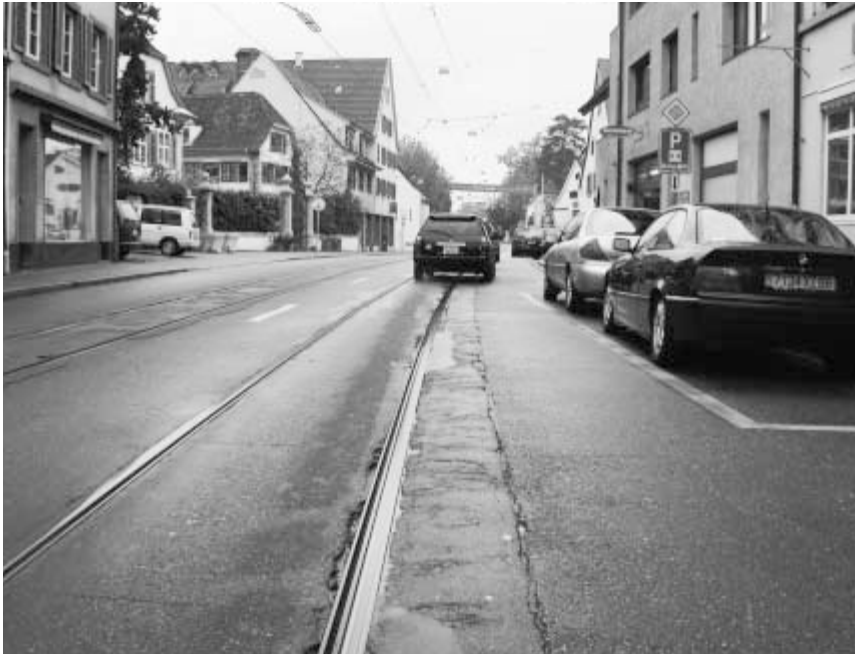
Auslöser für die geplante umfassende Sanierung der Baselstrasse zwischen Schmiedgasse und der Tramschlaufe vor der Fondation Beyeler ist der schlechte Zustand der Tramgeleise. Die Parkplätze vor dem Restaurant «Siebenpfund» (rechts) sollen aufgehoben und dafür Ersatz vor dem Restaurant «Han» (links im Hintergrund) geschaffen werden.
