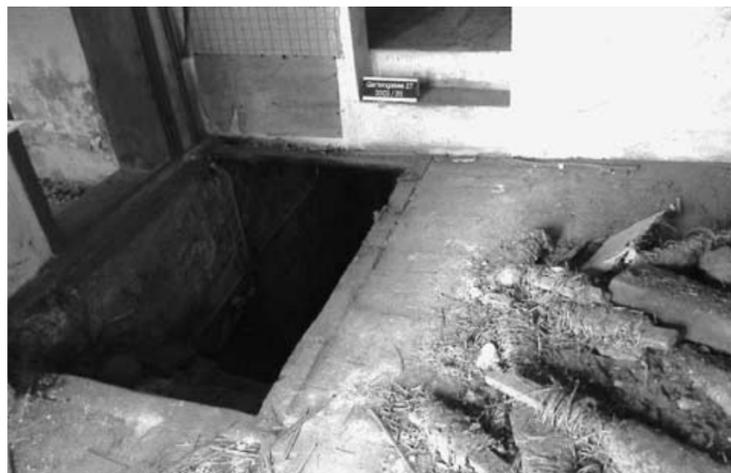
Zeugnisse alter Handwerkstechniken: Für die Wände und Zwischendecken wurden mit Stroh und Lehm umwickelte Holzbalken (rechts) verwendet.
